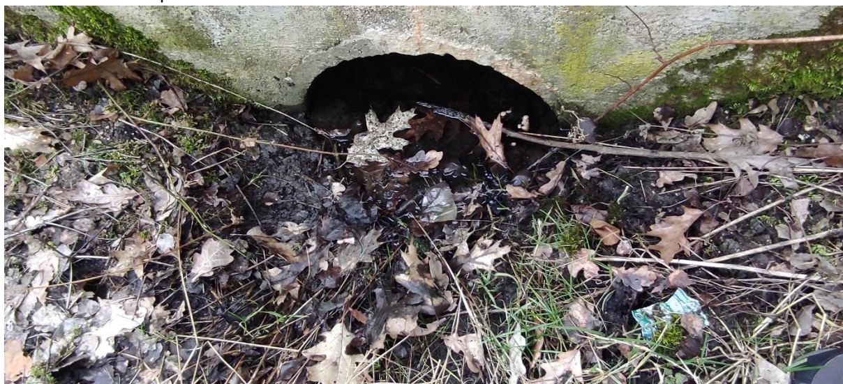
Zanesená roura naplaveninami a nečistotami
