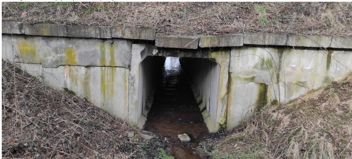
Stávající rámový propustek, propadlá římsa
