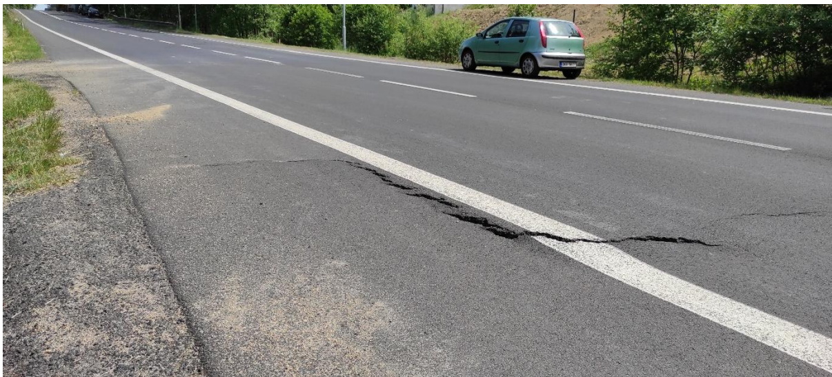
Trhlina ve vozovce v sesuvném území
